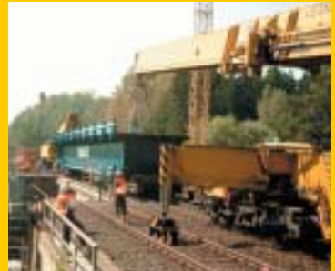
Einbau einer 120 t-Stahlbrücke im Tandemeinsatz
