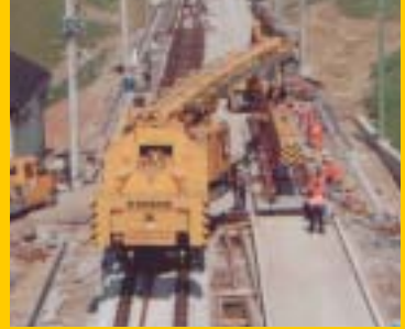
Einbau einer Hochgeschwindigkeits-Weiche
