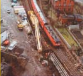
Profilfreies Einheben einer Hilfsbrücke
