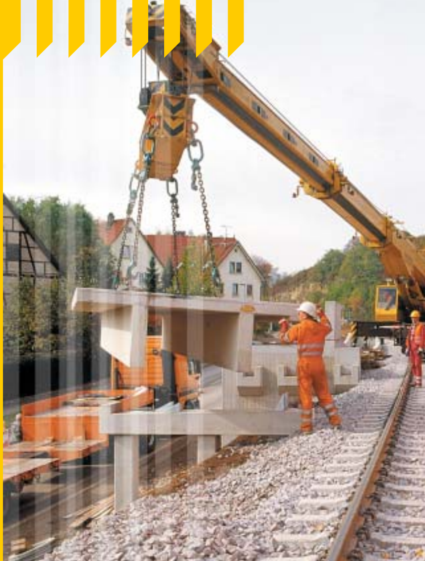
Profilfreie Montage von Betonfertigteilen
